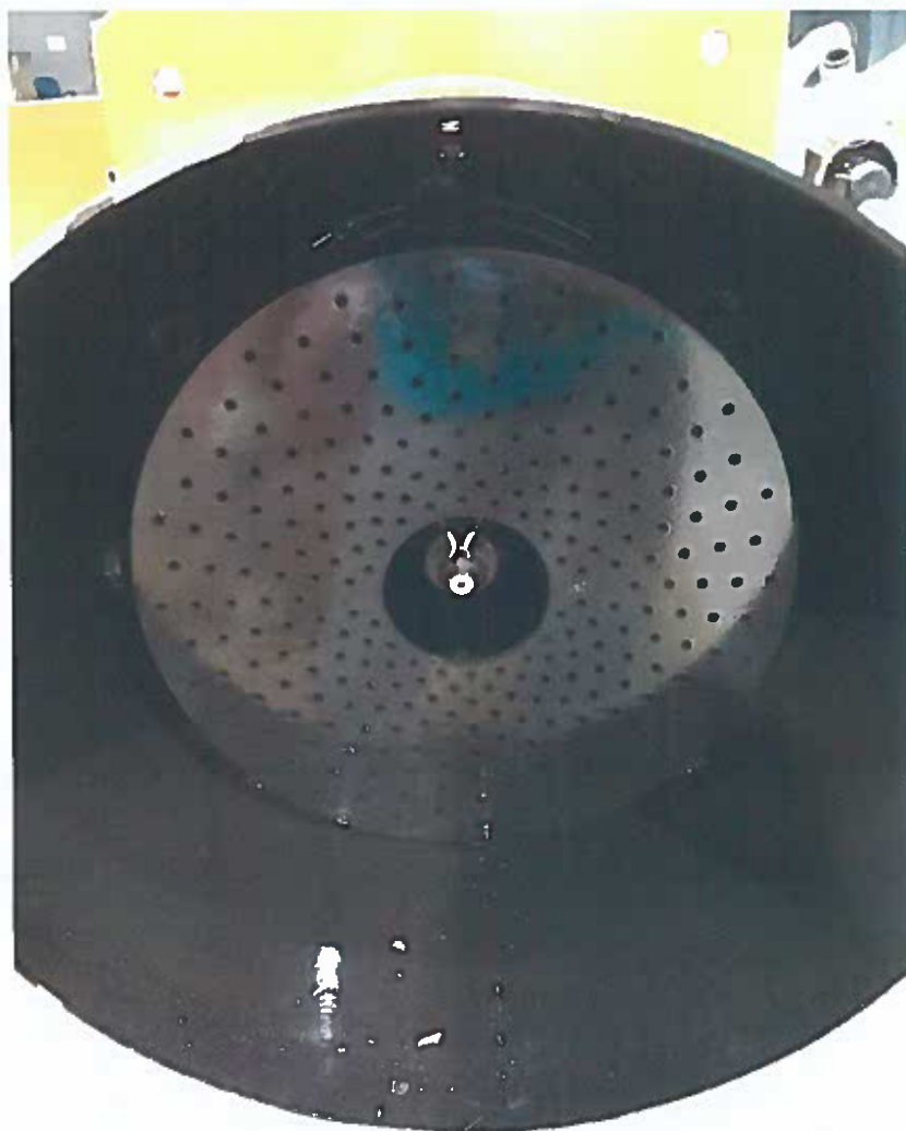
Фото 7 – Очаги коррозии на форсунке и пламенной голове отсутствуют
