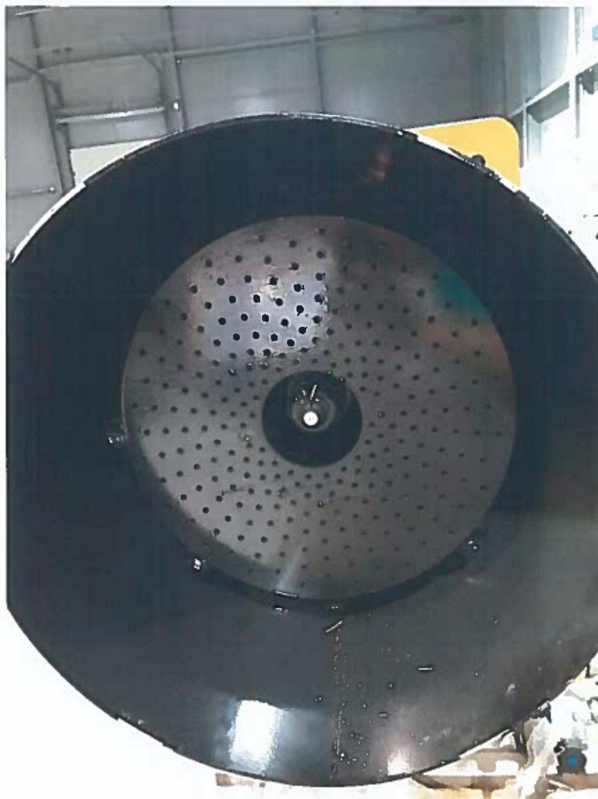
Фото 7 – Очаги коррозии на форсунке и пламенной голове отсутствуют
