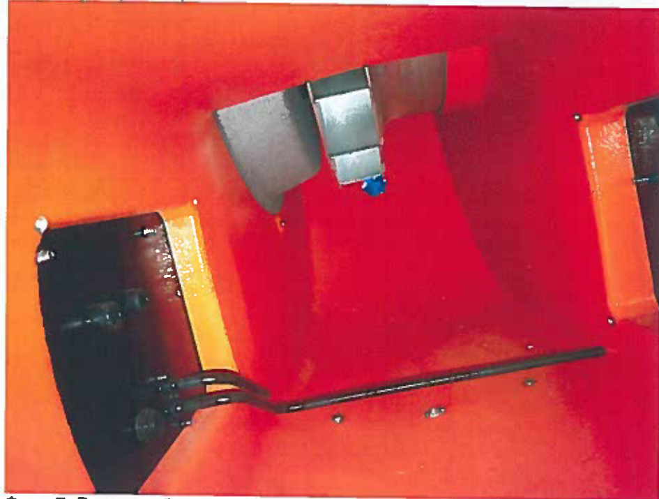
Фото 7- Вид на рабочее колесо вентилятора горелки
