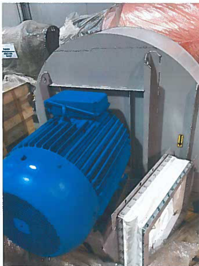
Фото 10 – Вентилятор горелочного устройства
