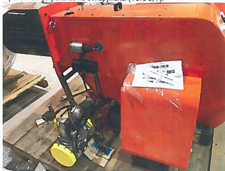
Фото 6 – Очаги коррозии на горелочном устройстве отсутствуют
